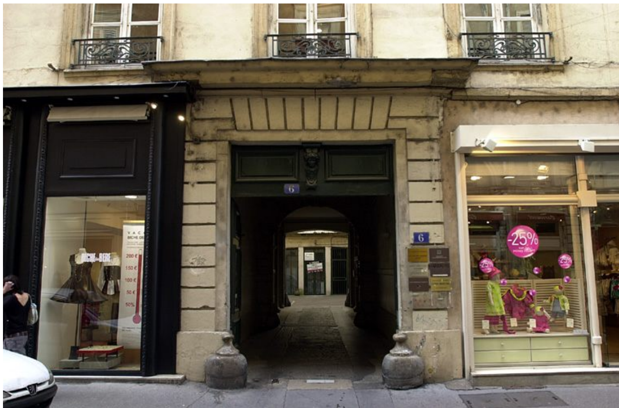
Lotissement : 6 rue Emile-Zola, porche d'entrée de l'immeuble
