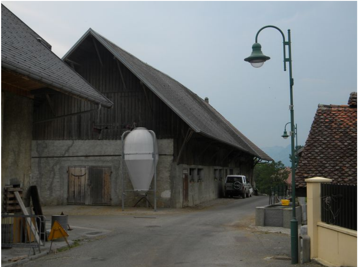
Vue des parties transformées de la ferme.
