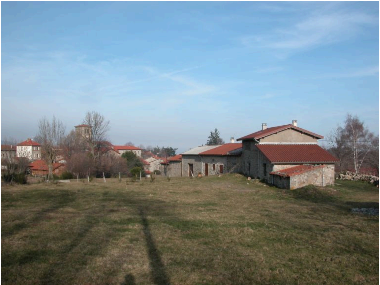
Vue générale de la ferme de trois-quarts arrière depuis le sud-ouest.
