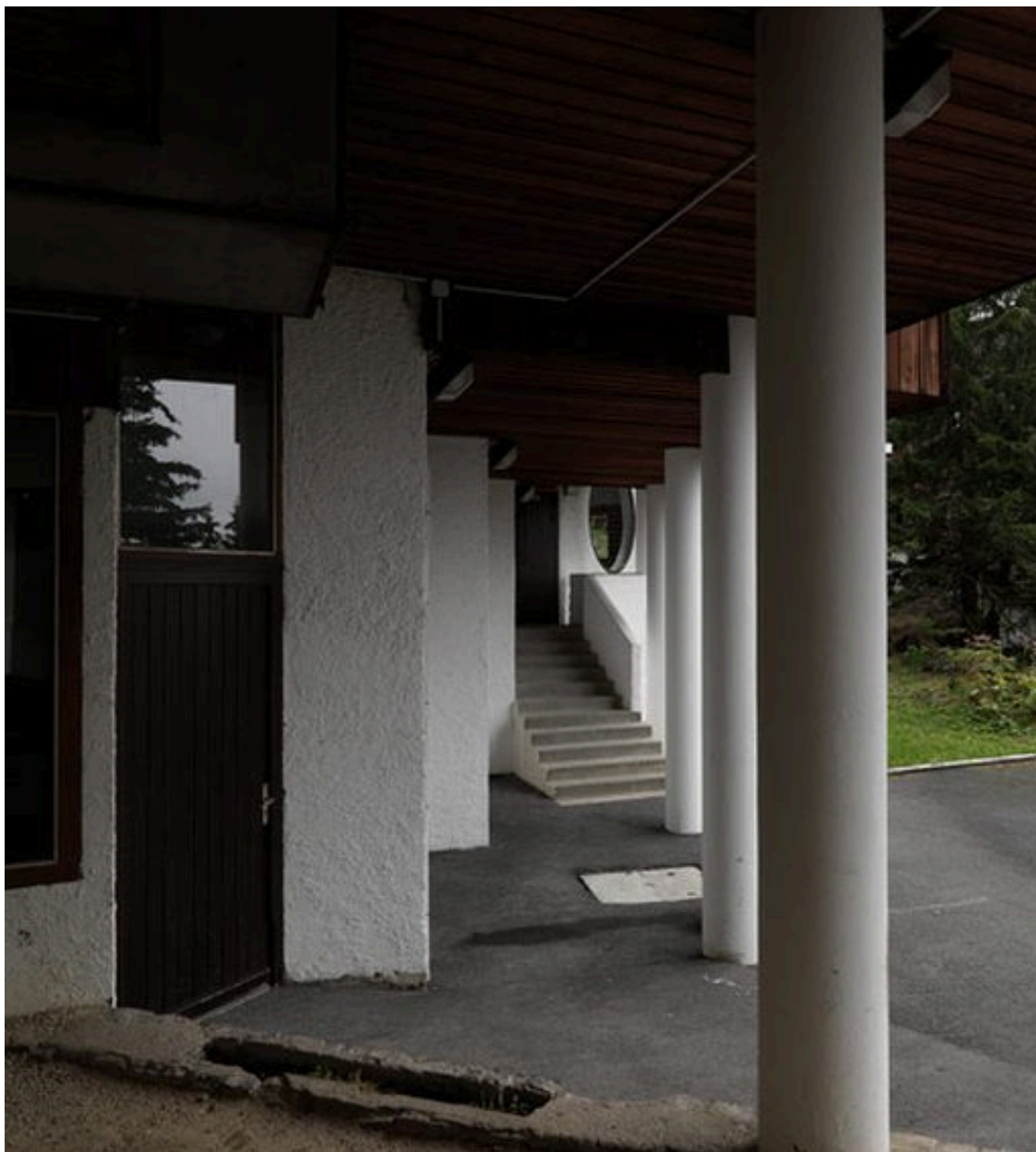
Galerie de passage en soubassement
