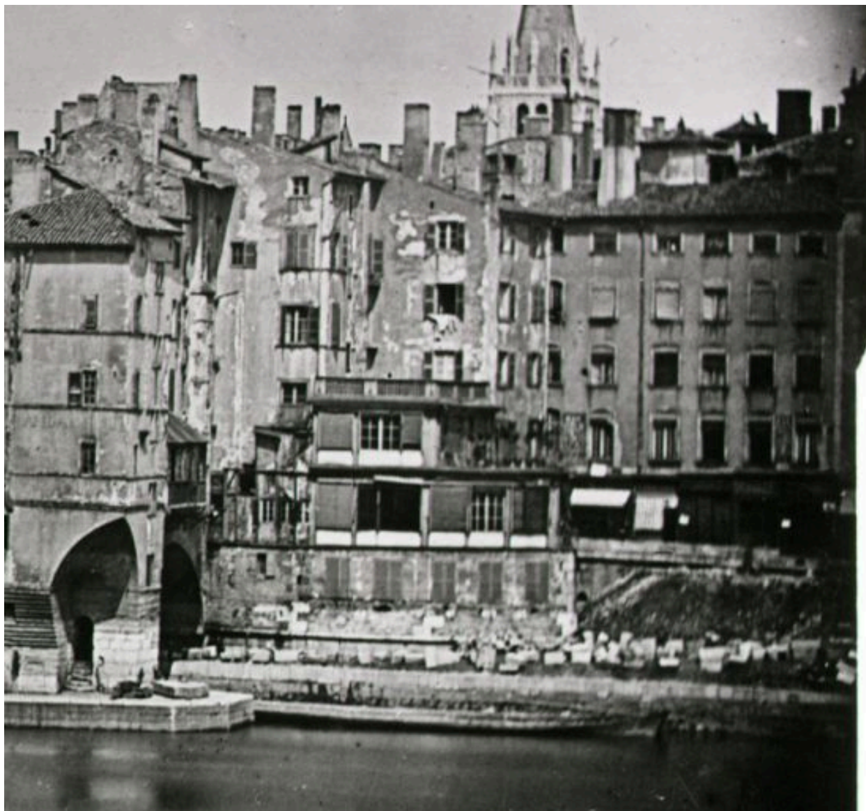
Démolition du Pont du Change [début du quai Saint-Antoine], détail d'une fotogr., ca 1846-1847
