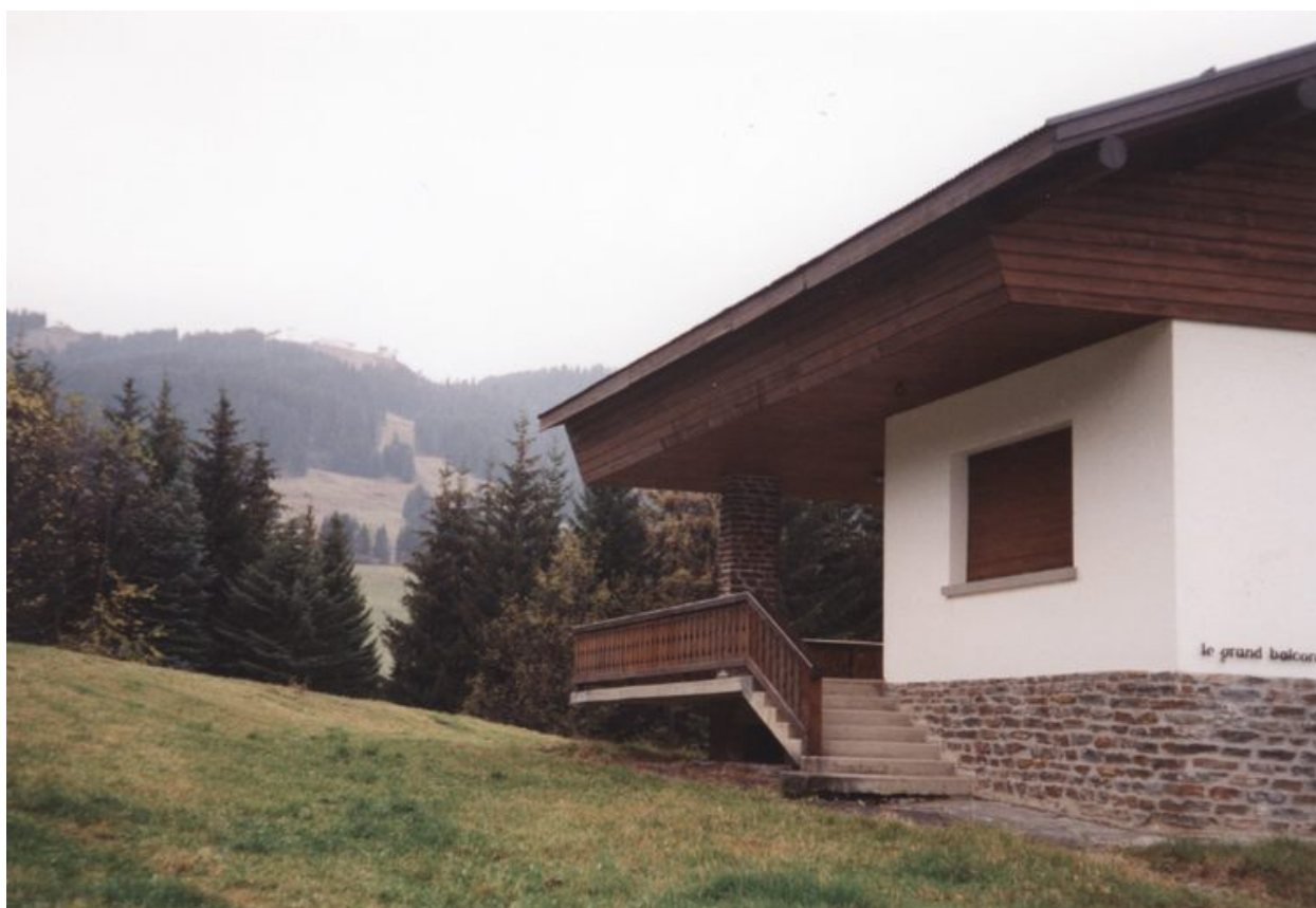
Façade sud-est. Escalier vers le balcon
