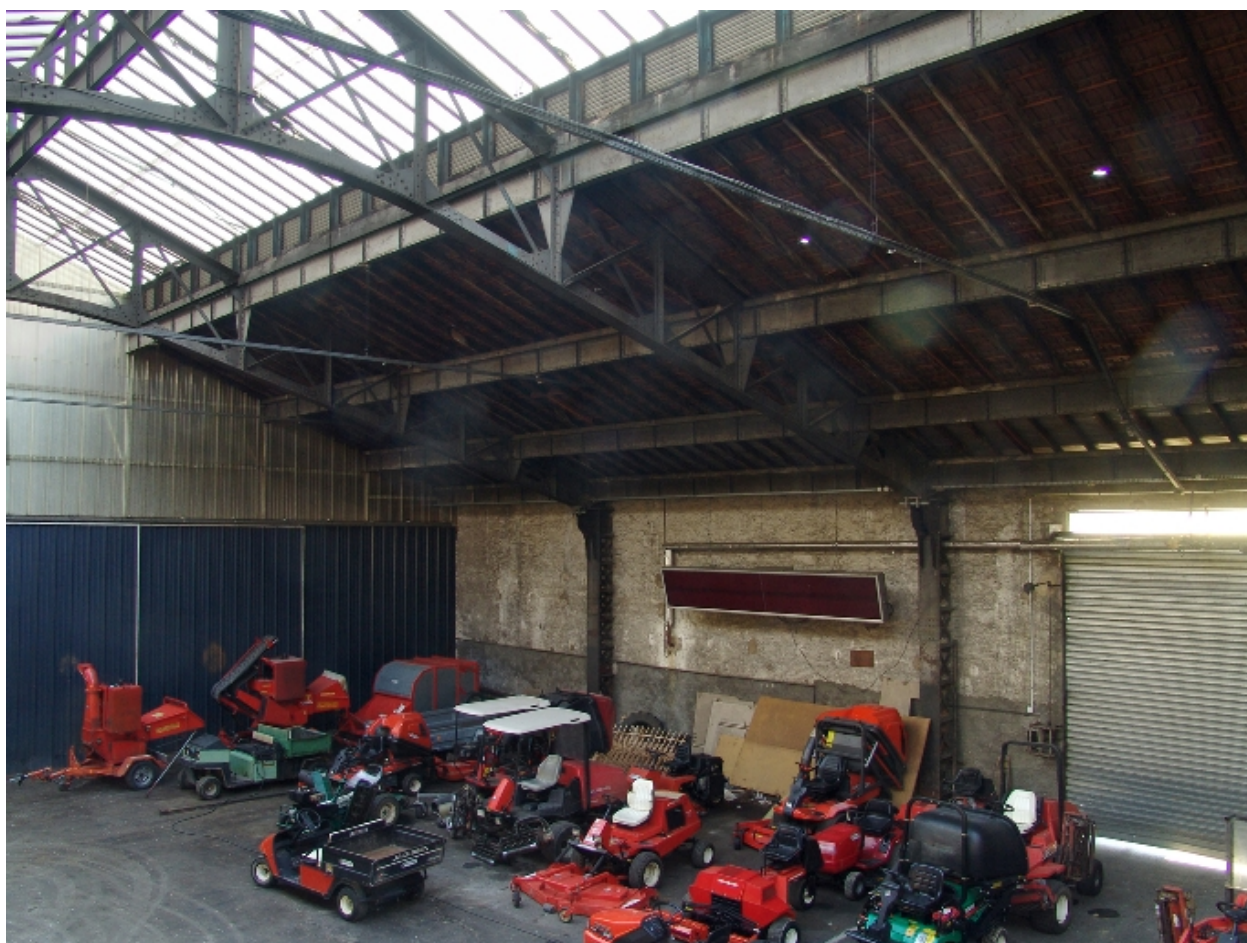
Entrée de la grande halle
