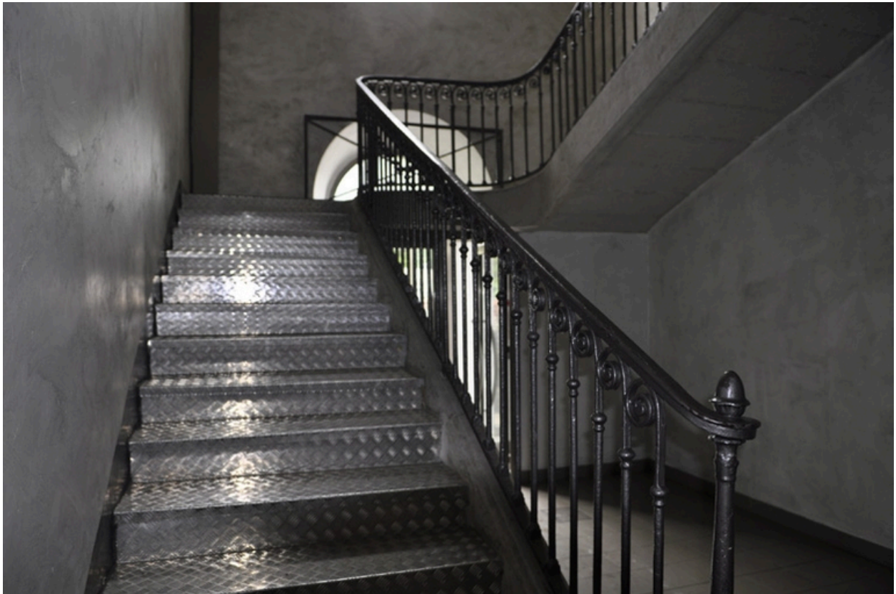
Vue de l'escalier latéral est.
