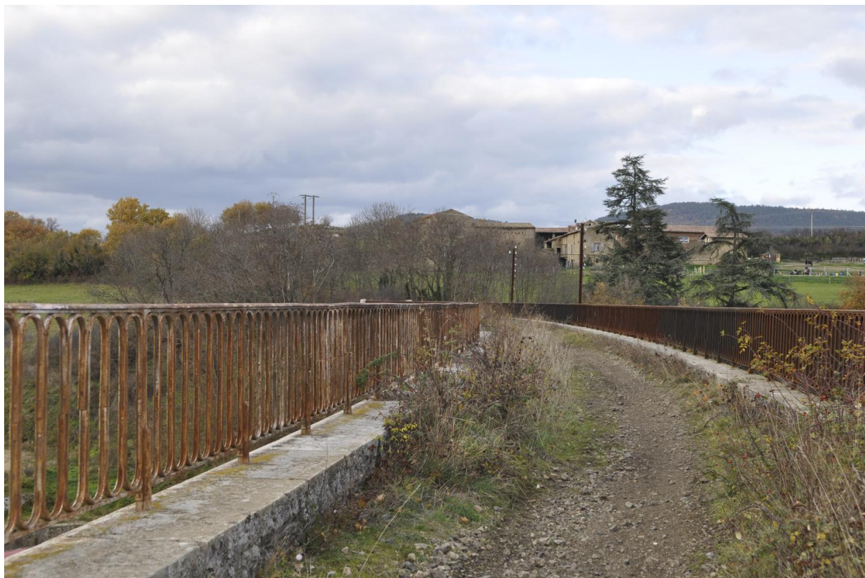
Tablier viaduc de Pupil : ancienne voie ferrée
