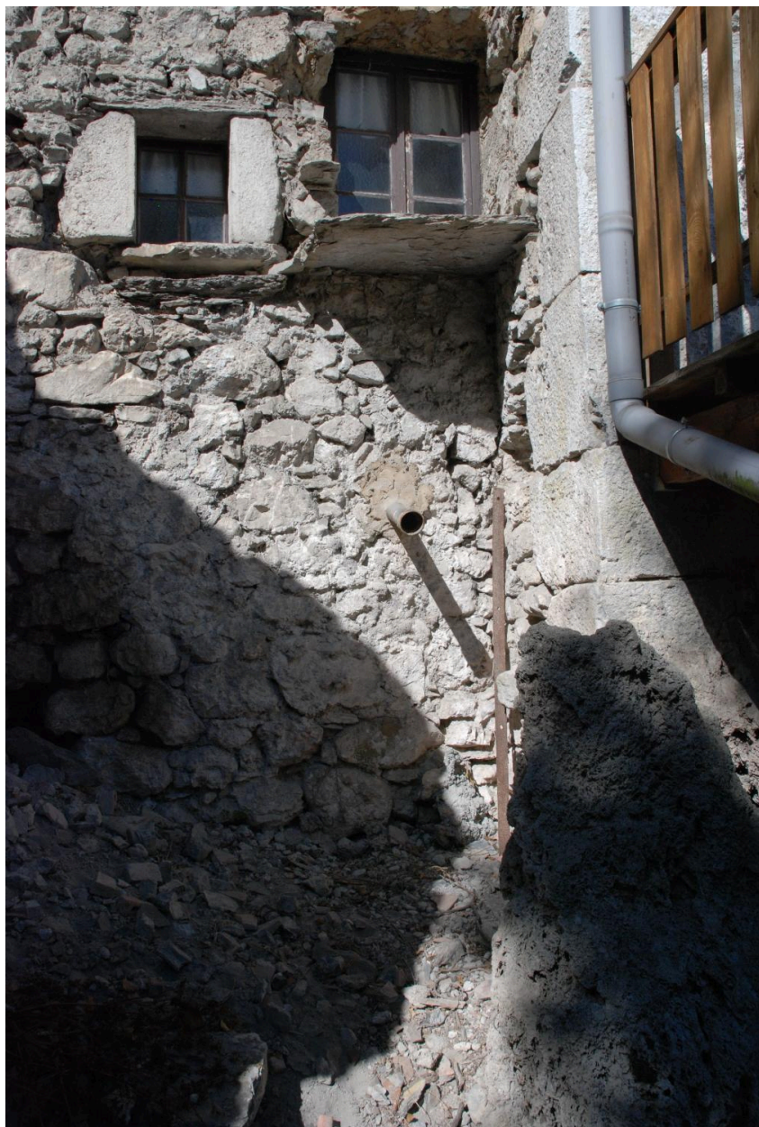
Détail de l'élévation sud (côté bief) : appuis en lauze.
