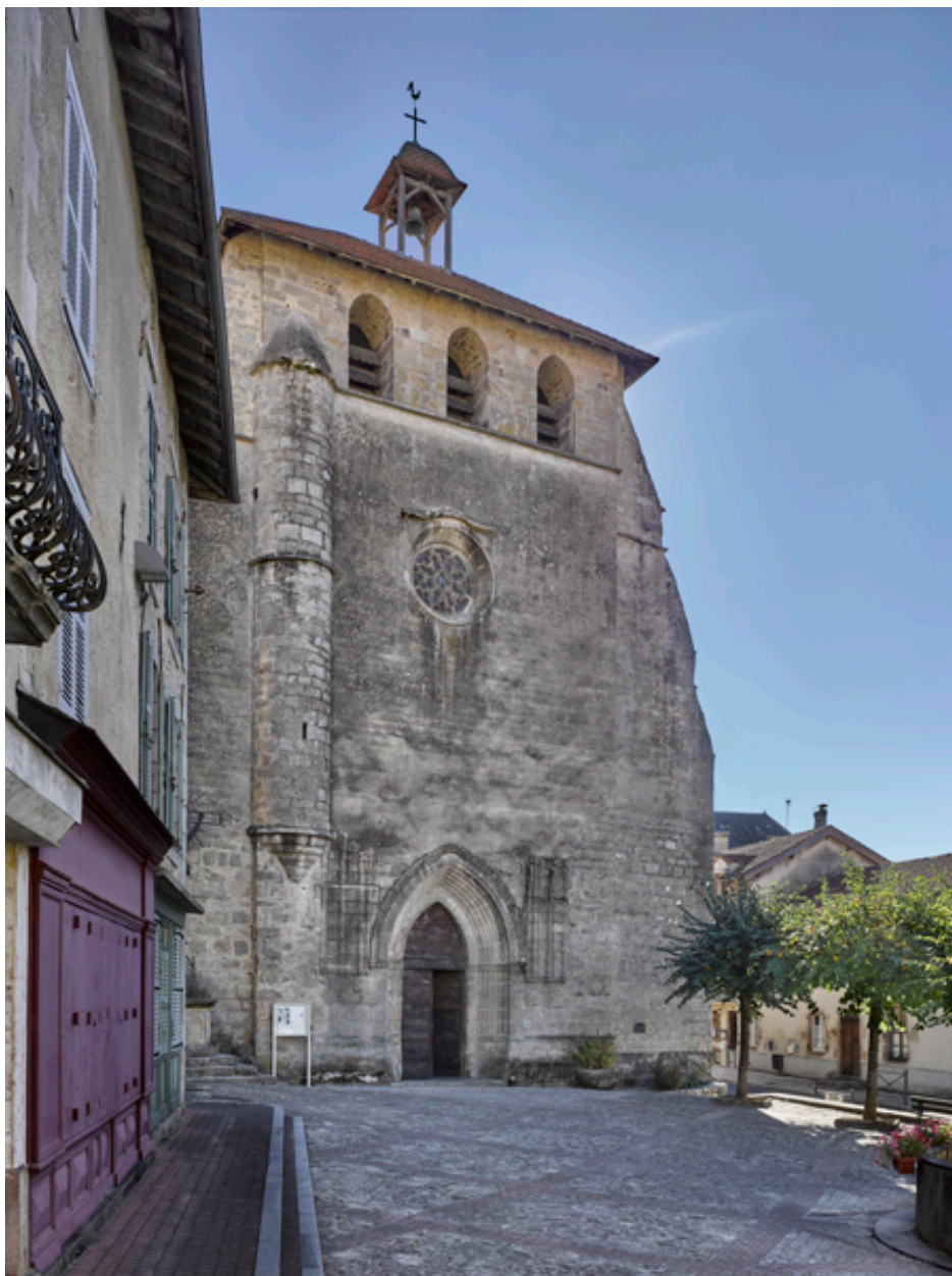
Vue générale de la façade occidentale
