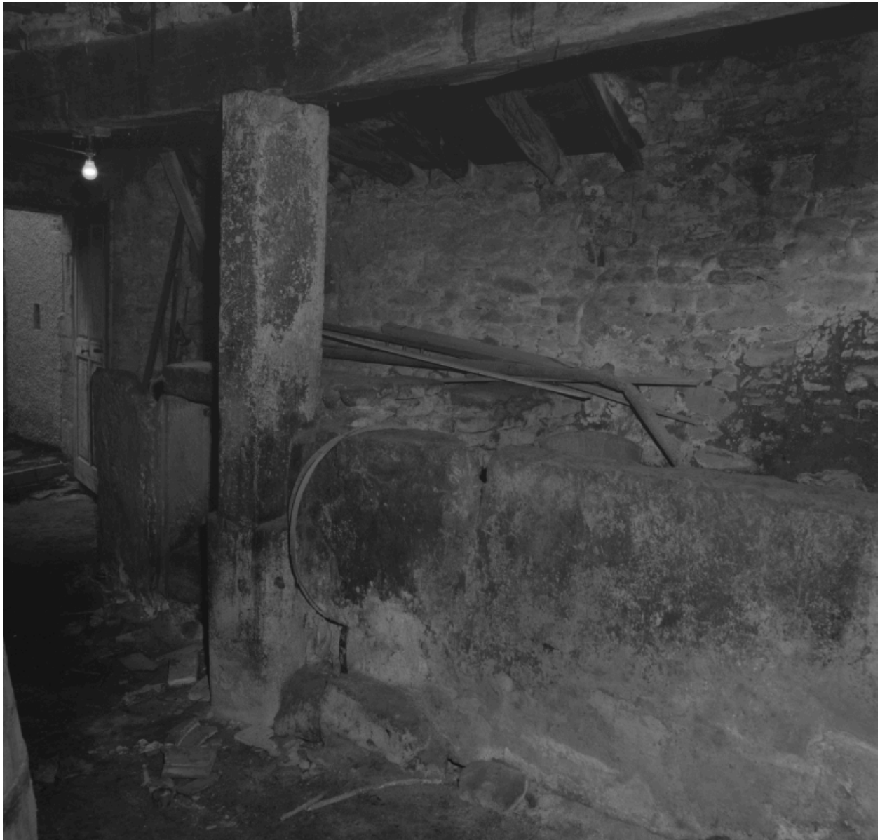
Rue des Fontaines, maison de type 6 (AX 199). Cave, en étage de soubassement : cuves à vin.
