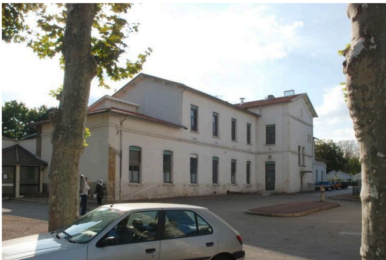
Bâtiment 331, façade principale (nord) depuis le nord-ouest
