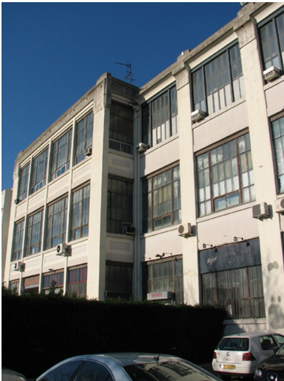
Détail avant-corps est de bâtiment
