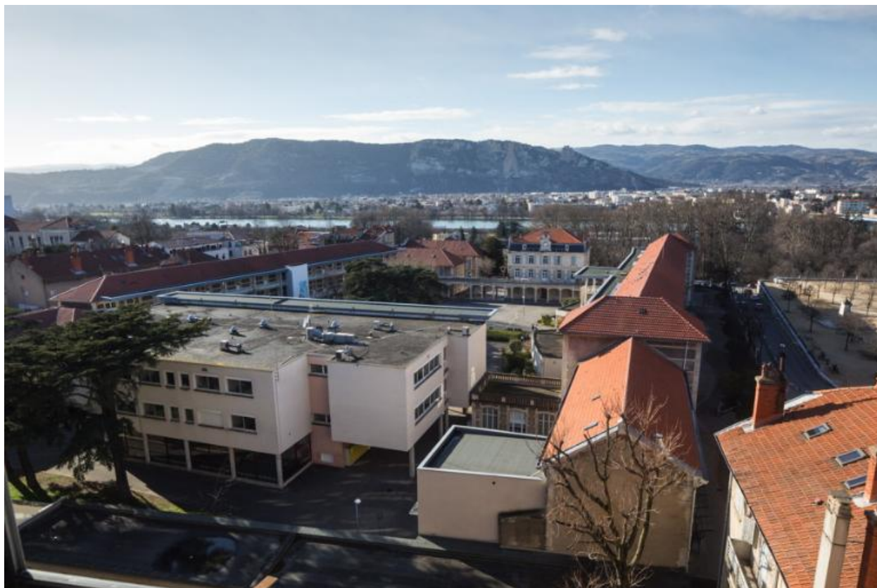
Vue surélevée depuis l'est
