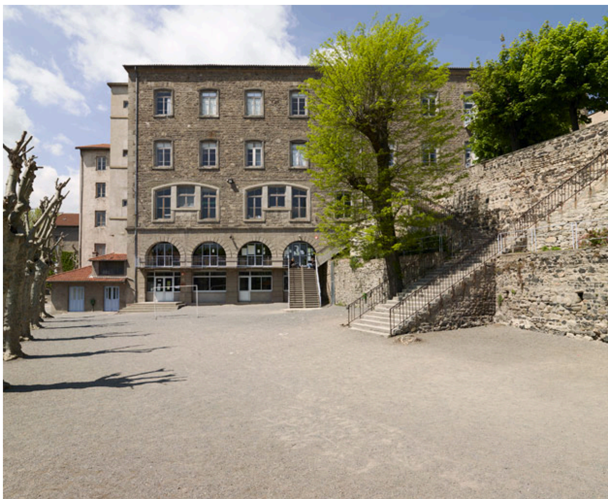
Vue partielle du bâtiment D depuis la terrasse inférieure.
