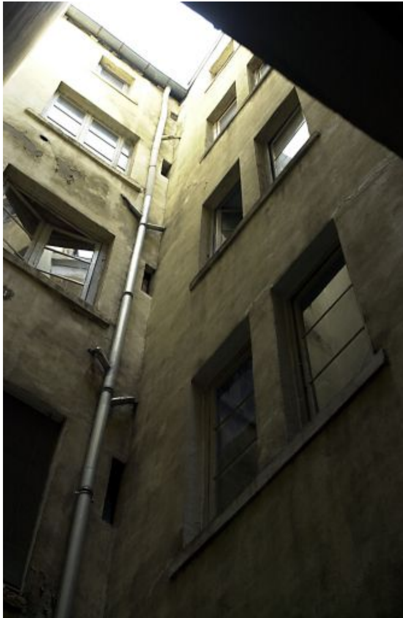
Cour, vue des 2 corps de bâtiment depuis l'escalier
