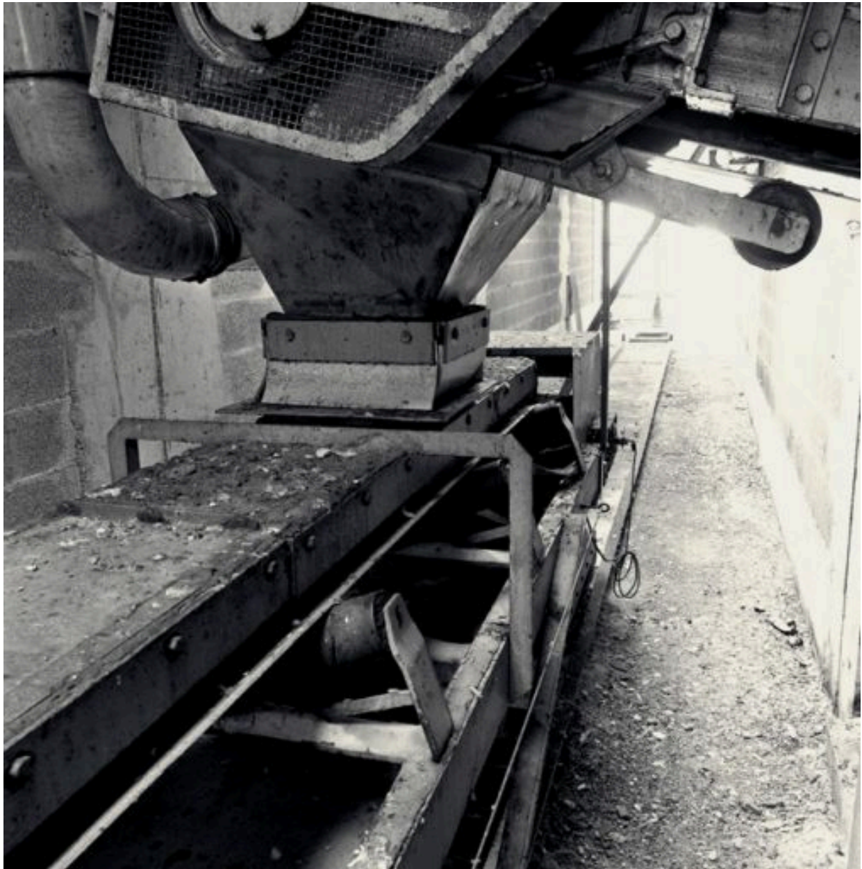
Intérieur des silos, la galerie supérieure : détail d'une trémie
