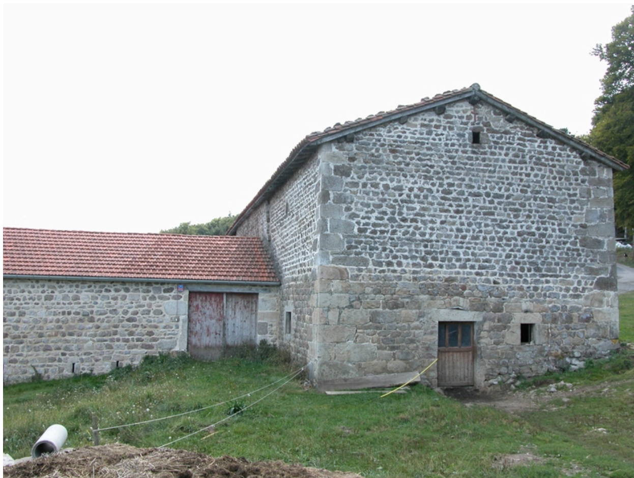
Vue d'ensemble depuis le nord (pignon de la grange-étable, passage couvert).
