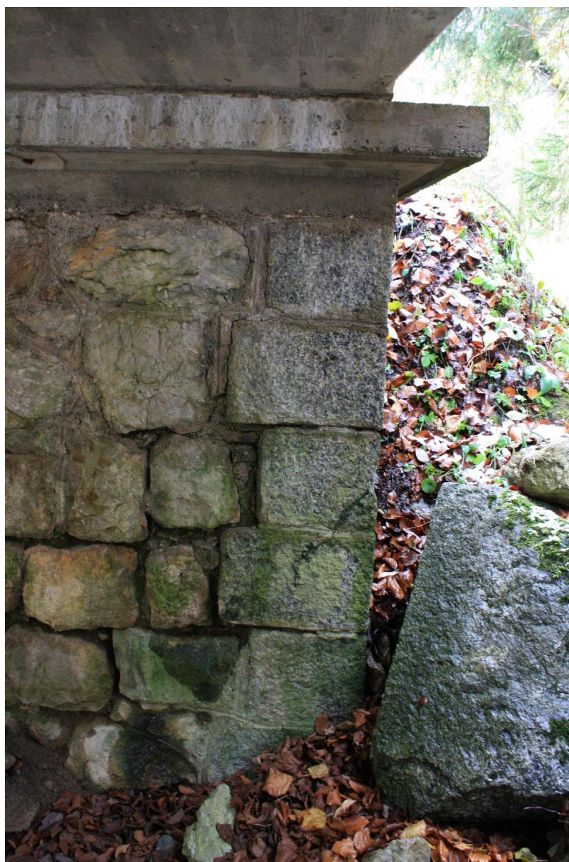
Pont de la Vernaz, détail harpage
