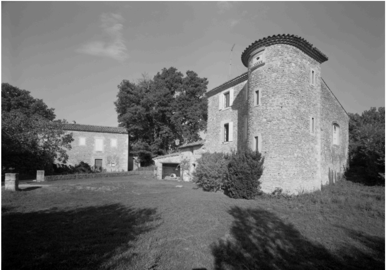
Pontillon et Roustan. Vue d'ensemble de la ferme dite Le Moulin qui dépendait de la maison de notable dite Flachère de Roustan. (D3 663/667)
