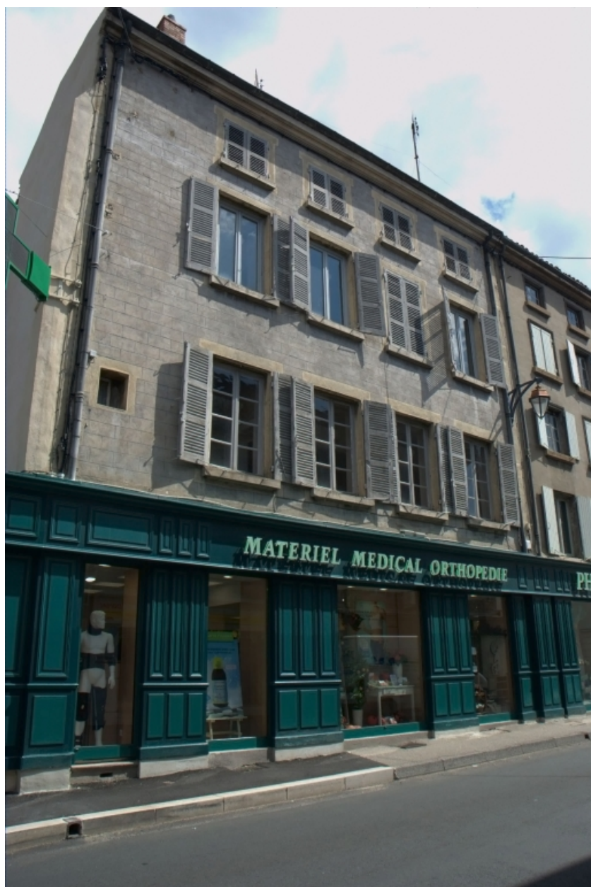
Îlot 4. Clermont (rue de) 51. Vue générale de la façade sur rue.
