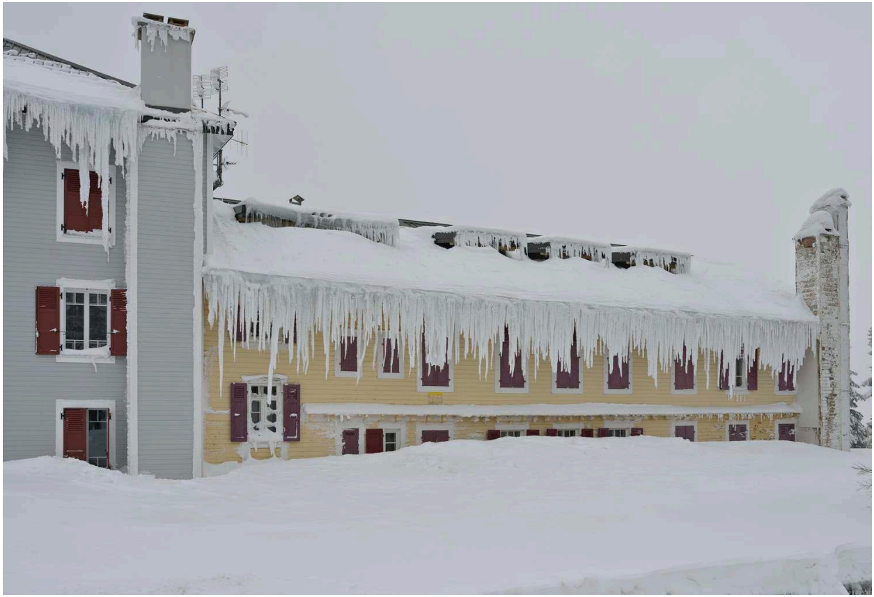
Façade arrière, détail sous la neige.
