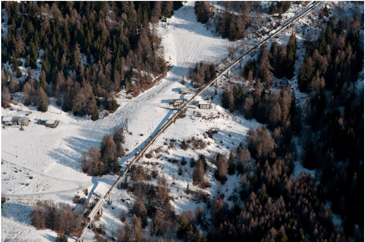
Vue aérienne de la ligne du funiculaire Arc-en-Ciel depuis le nord-ouest
