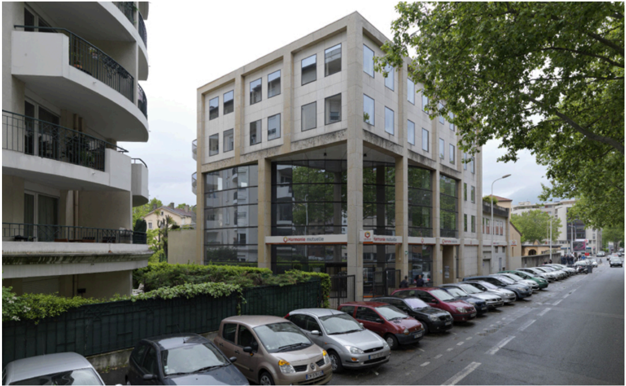
Vue générale depuis le nord
