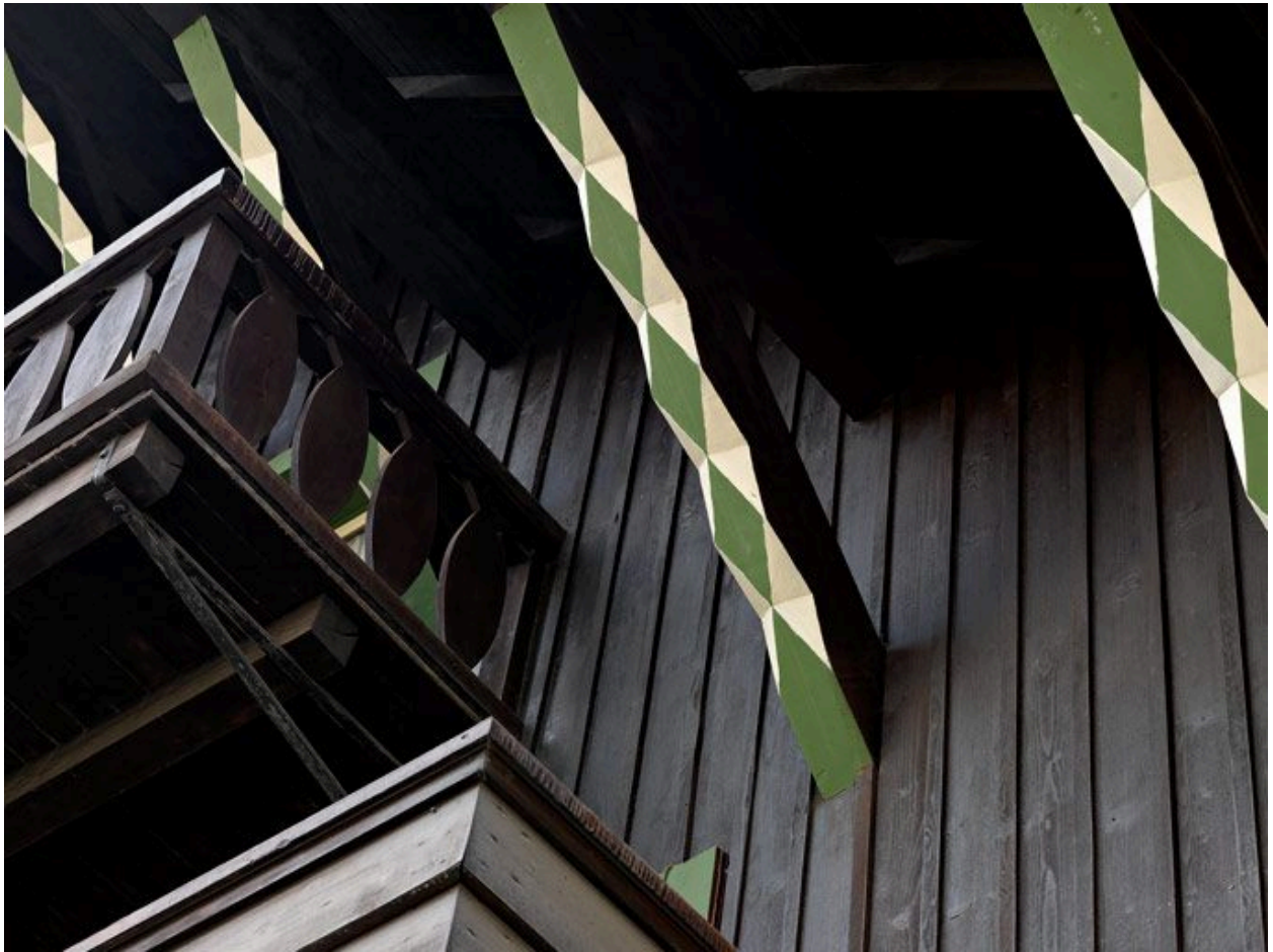
Chalet Reine des neiges, 456 route de Rochebrune, construit en 1937. Aisseliers d'avant-toit
