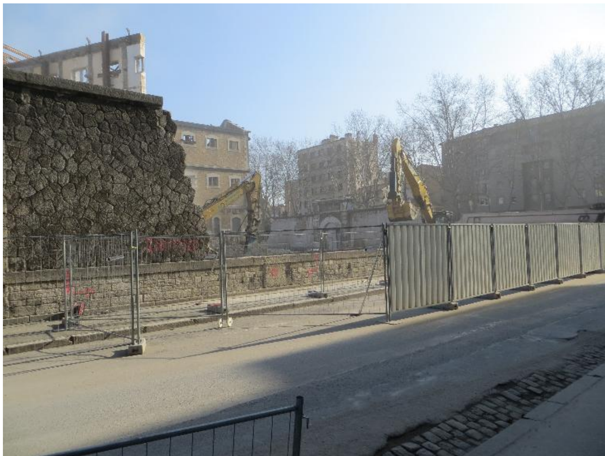
Etat au 19 février 2013 : revers du portail, aile sud et mur d'enceinte depuis la rue Smith
