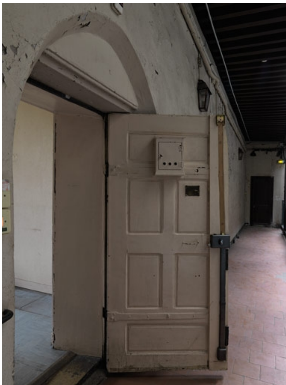
Bâtiment R. Revers de la 1ère porte de la galerie du 1er étage
