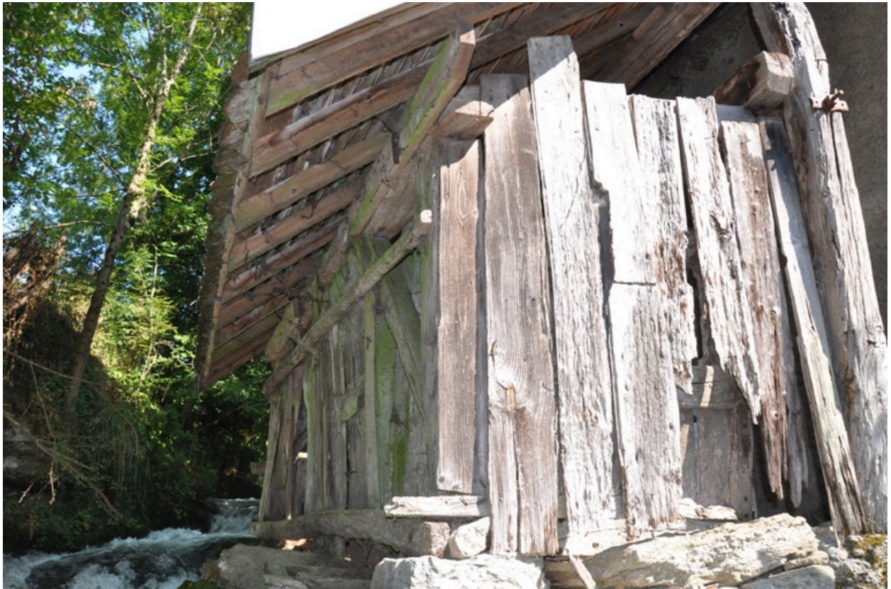
Vue de l'avant-toit sur la façade ouest protégeant la meule, 2009.
