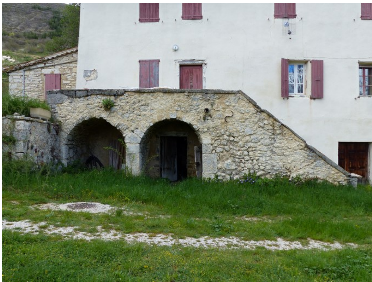
Bâtiment du logis. Elévation ouest, escalier extérieur et palier filant sur deux voûtes en berceau.
