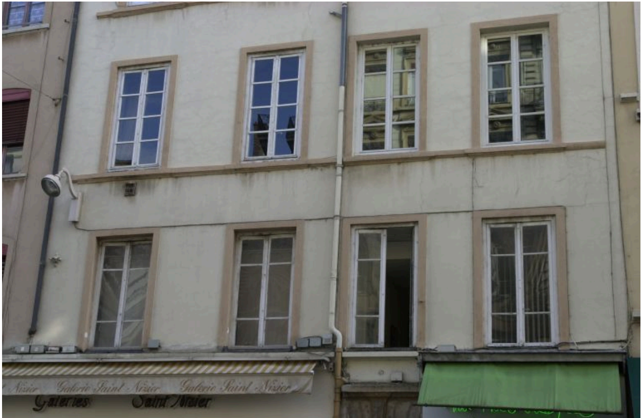
Façade sur rue, détail des 2e et 3e niveaux
