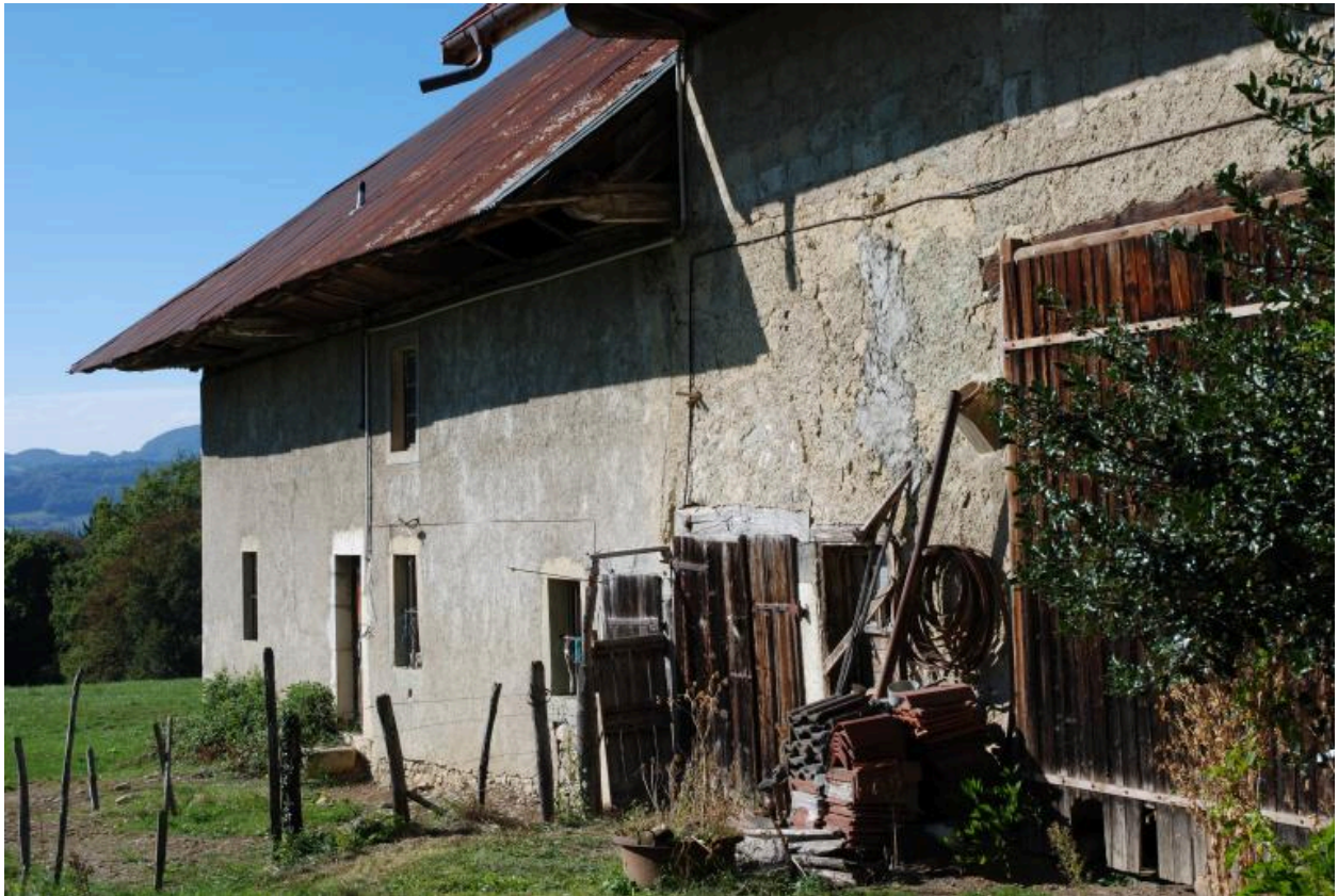
Vue de la grange-étable et de la ferme mitoyenne.
