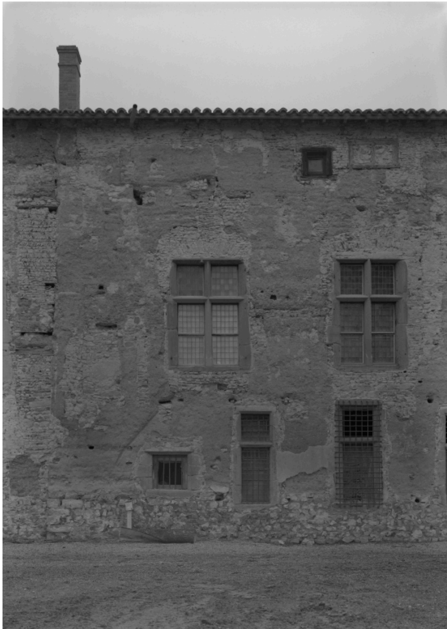
Façade sur jardin du corps de galerie après décroûtage : détail de la partie nord du corps primitif.
