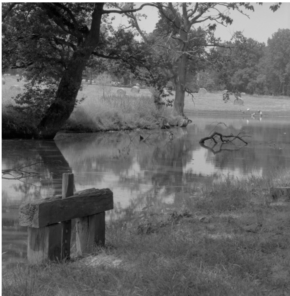
Vue d'une bonde originelle du canal, aujourd'hui déclassée.
