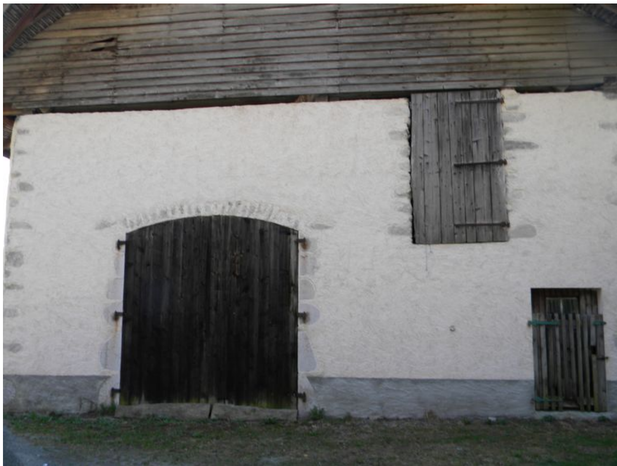
Détail des huisseries de ferme sur le pignon nord.
