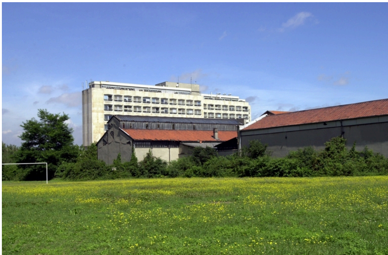
Vue sud-ouest du site
