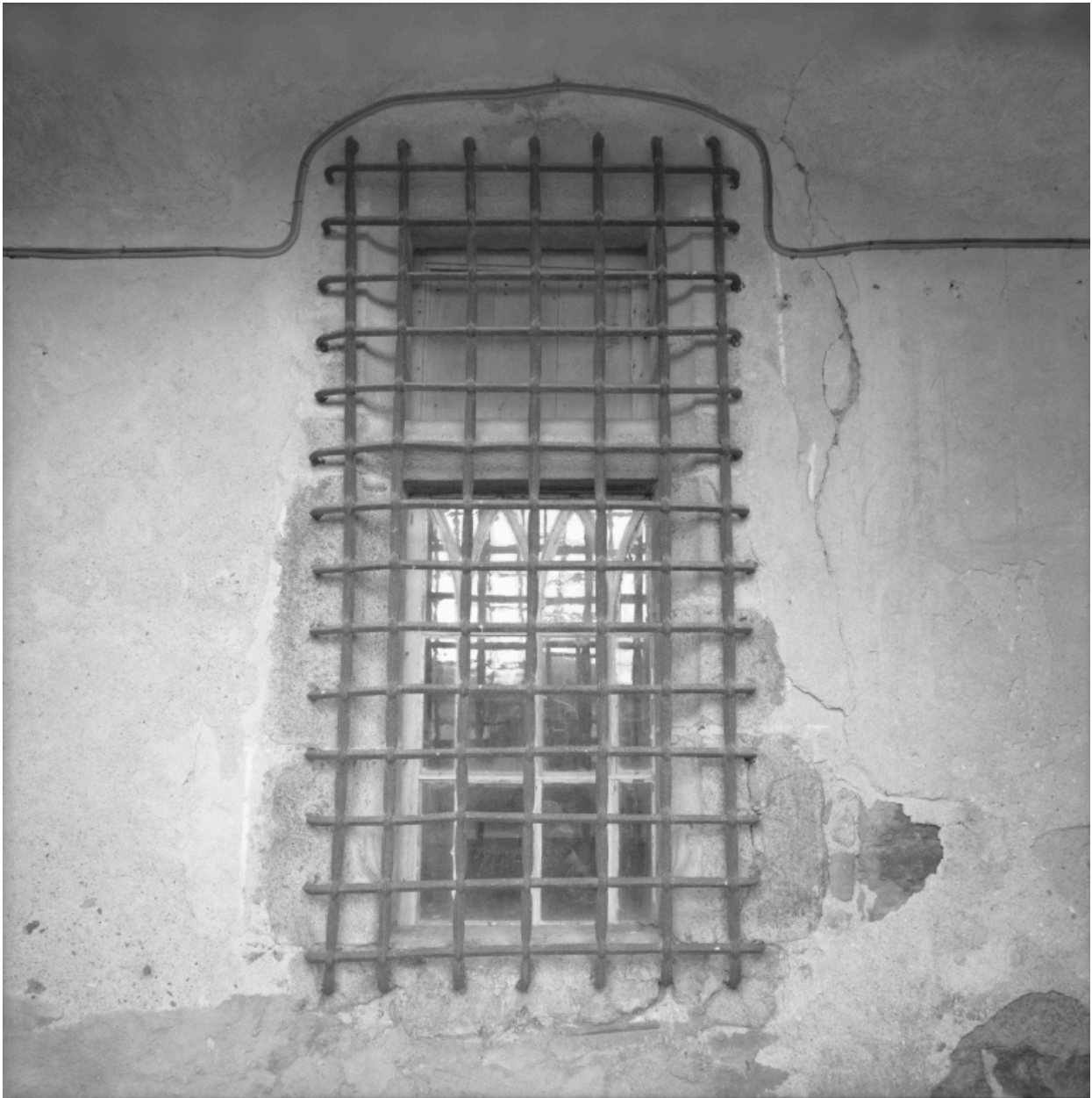
Corps de galerie, rez-de-chaussée, couloir donnant côté jardin : vue de la fenêtre de la cinquième pièce du portique, du sud.
