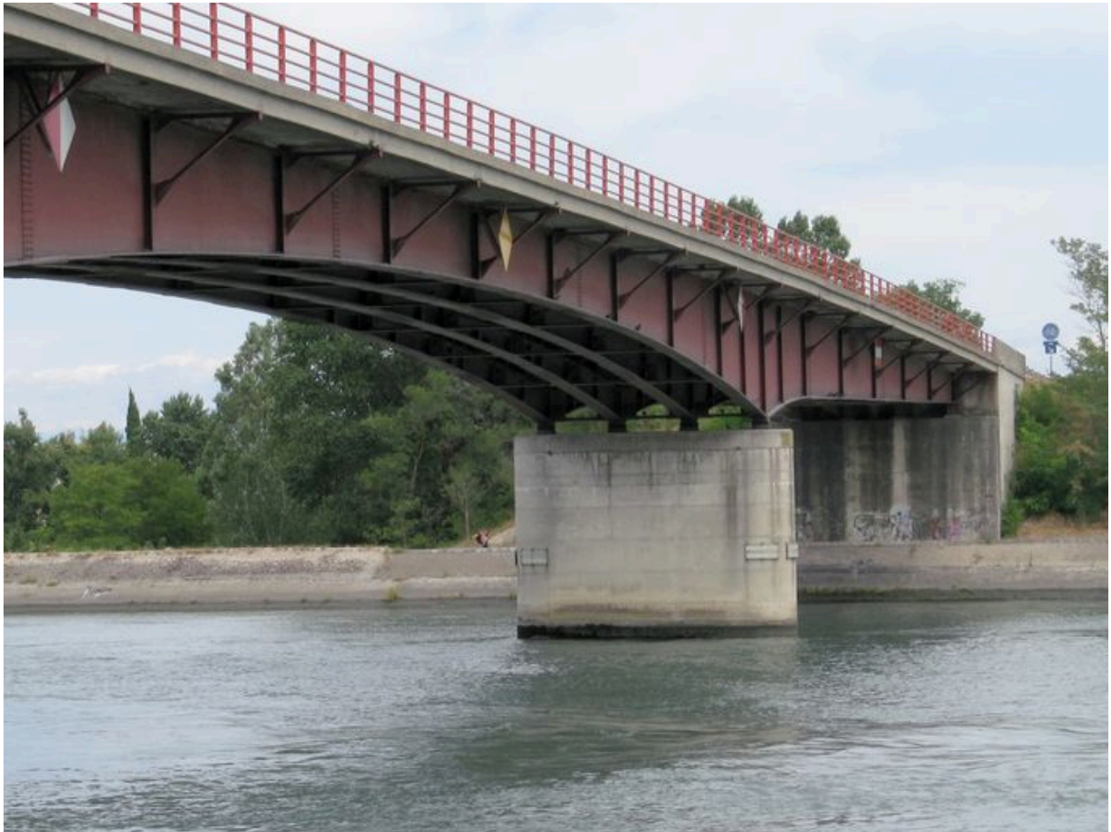
Tablier et pile gauche, de côté, face aval, vue partielle (depuis la rive droite)
