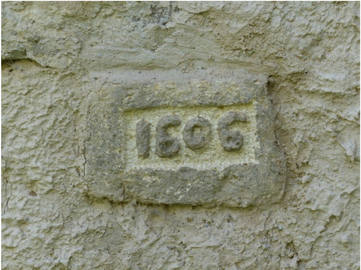
Partie est. Elévation nord, date portée (1606).
