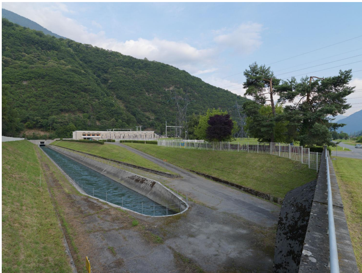
Vue d'ensemble du canal de fuite
