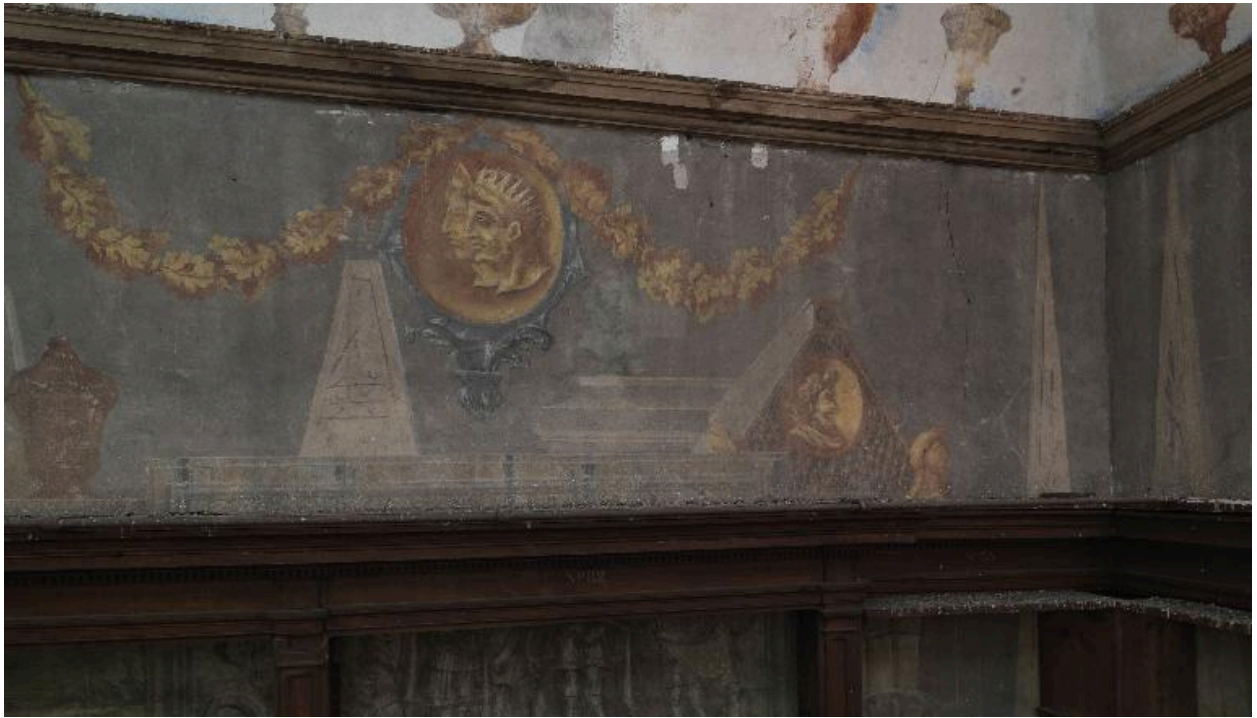
Mur nord, partie supérieure latérale droite
