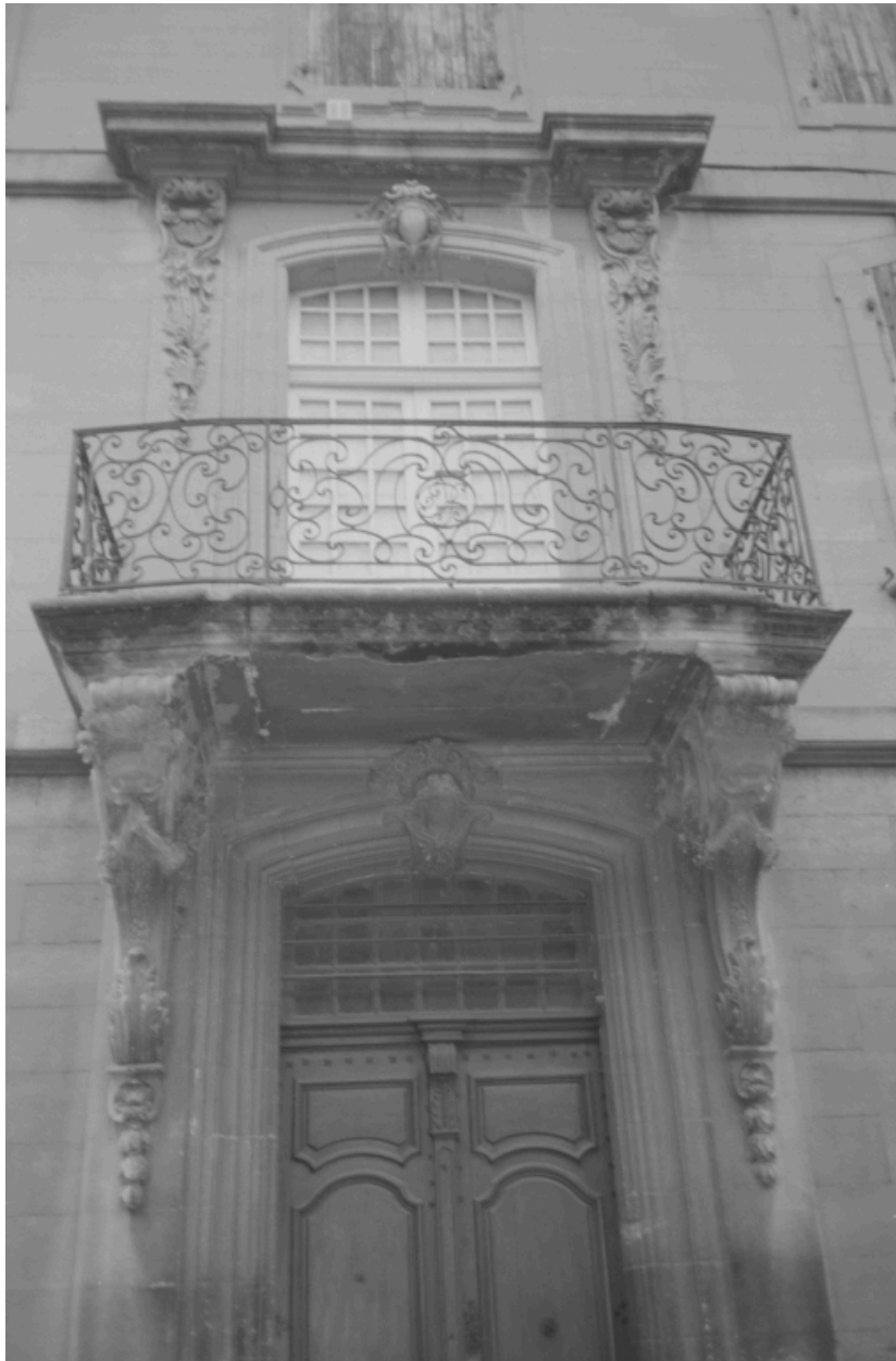
Façade sur rue, détail de la travée axiale.
