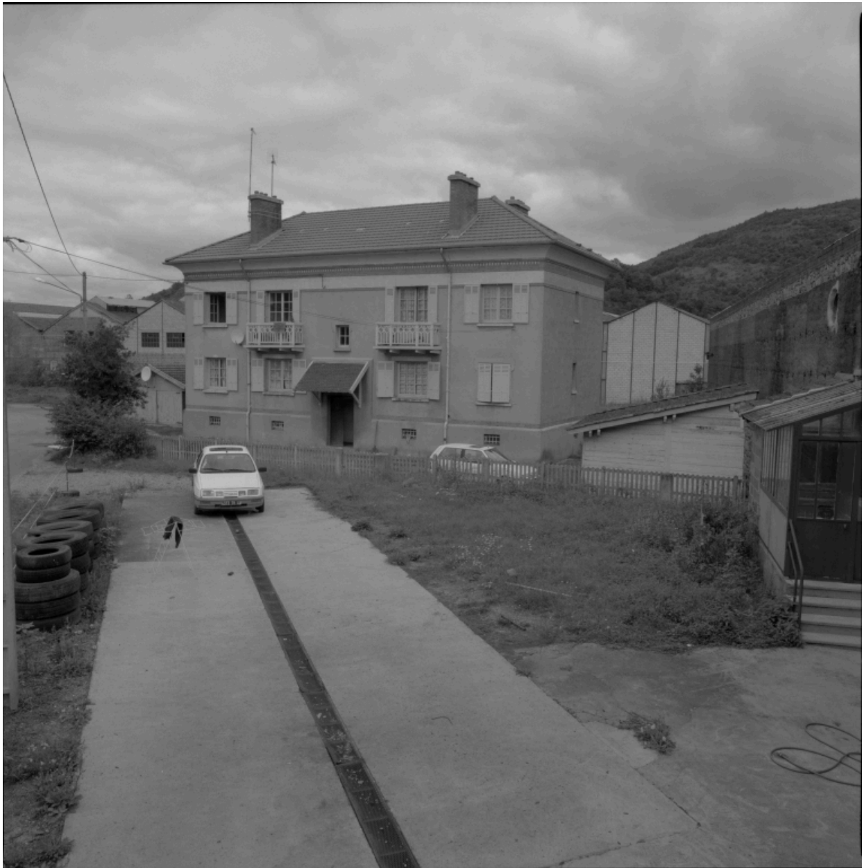
Sail-sous-Couzan, A la Gare, 1986 A 396. Logement des employés de la gare. Vue d'ensemble.
