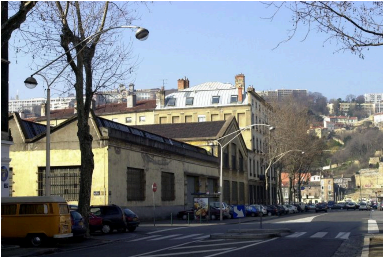
Vue d'ensemble depuis le cours Suchet
