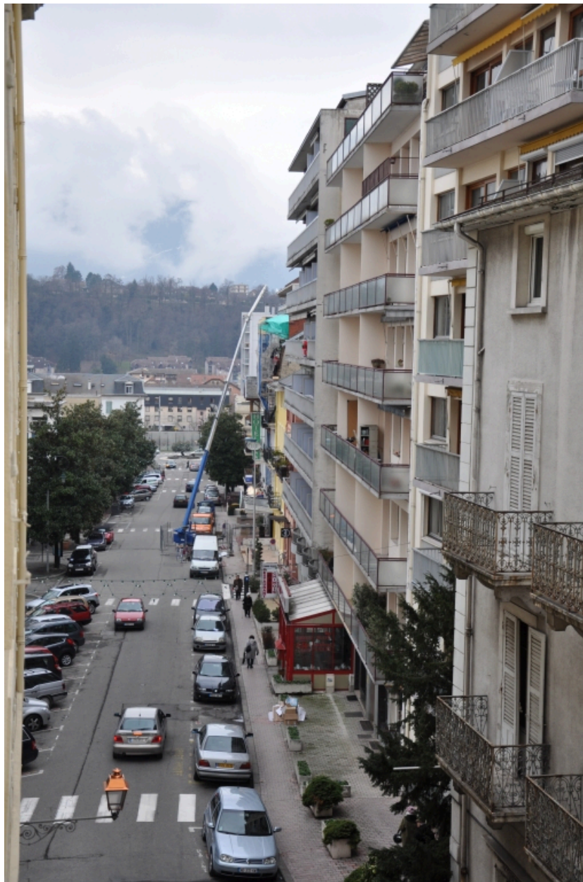
Vue générale prise de l'est
