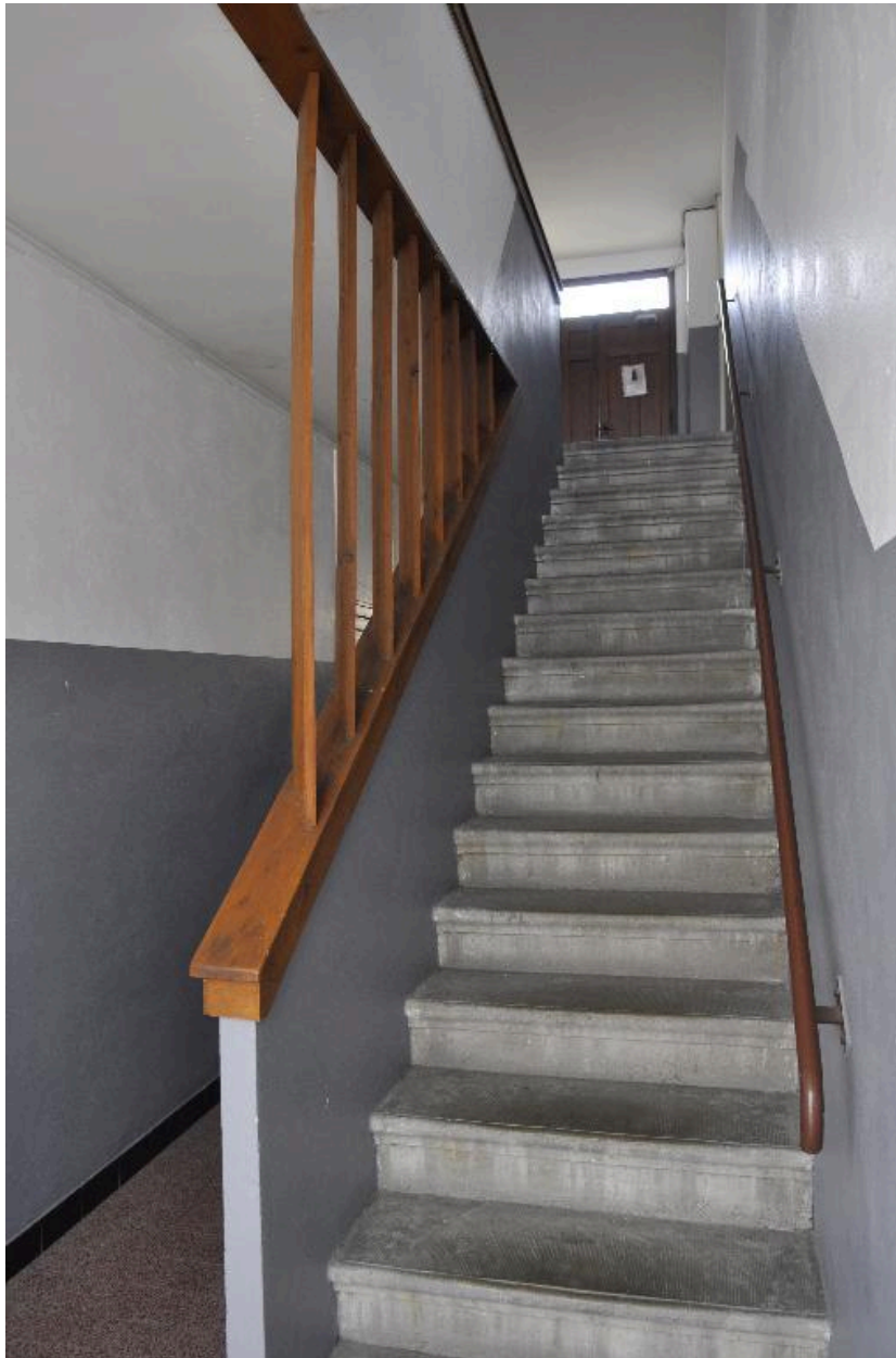
Vue intérieure, départ de l'escalier
