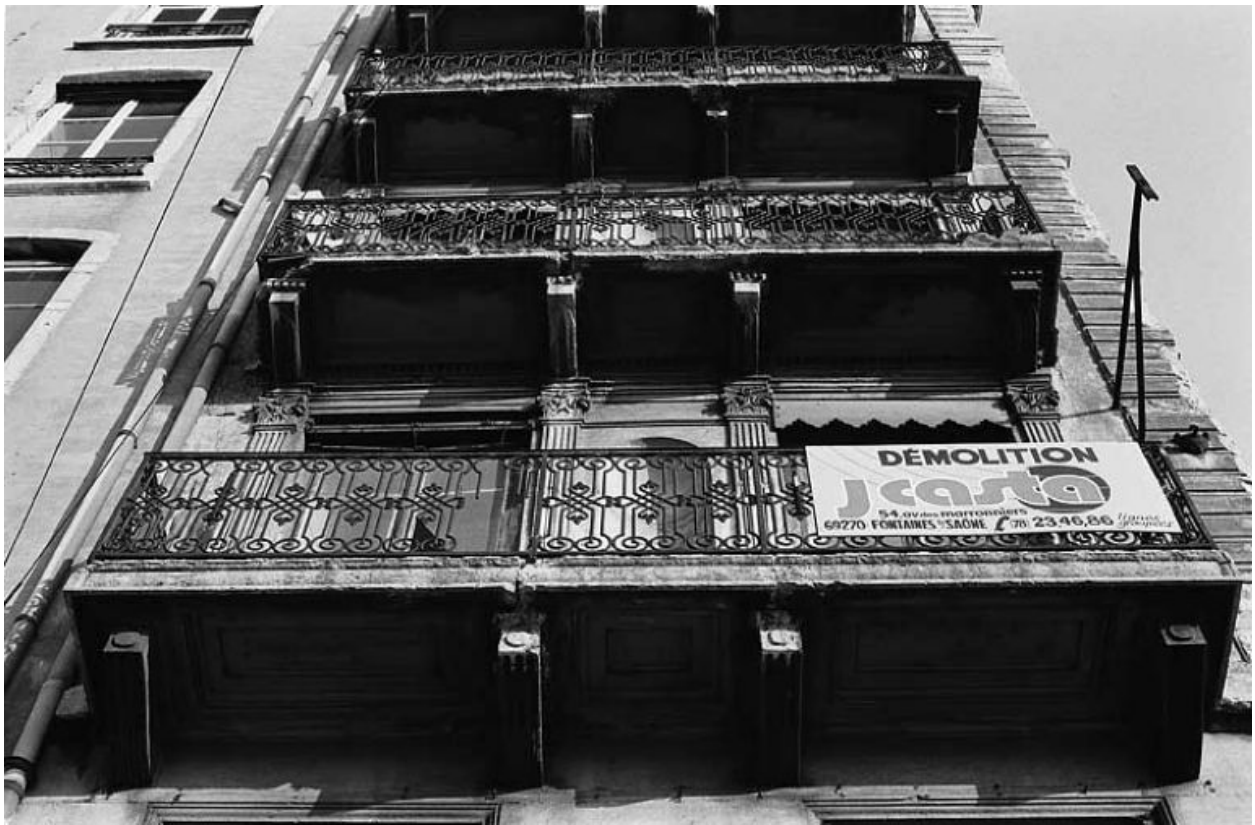
Façade sur le quai, balcons des niveaux 3 à 5
