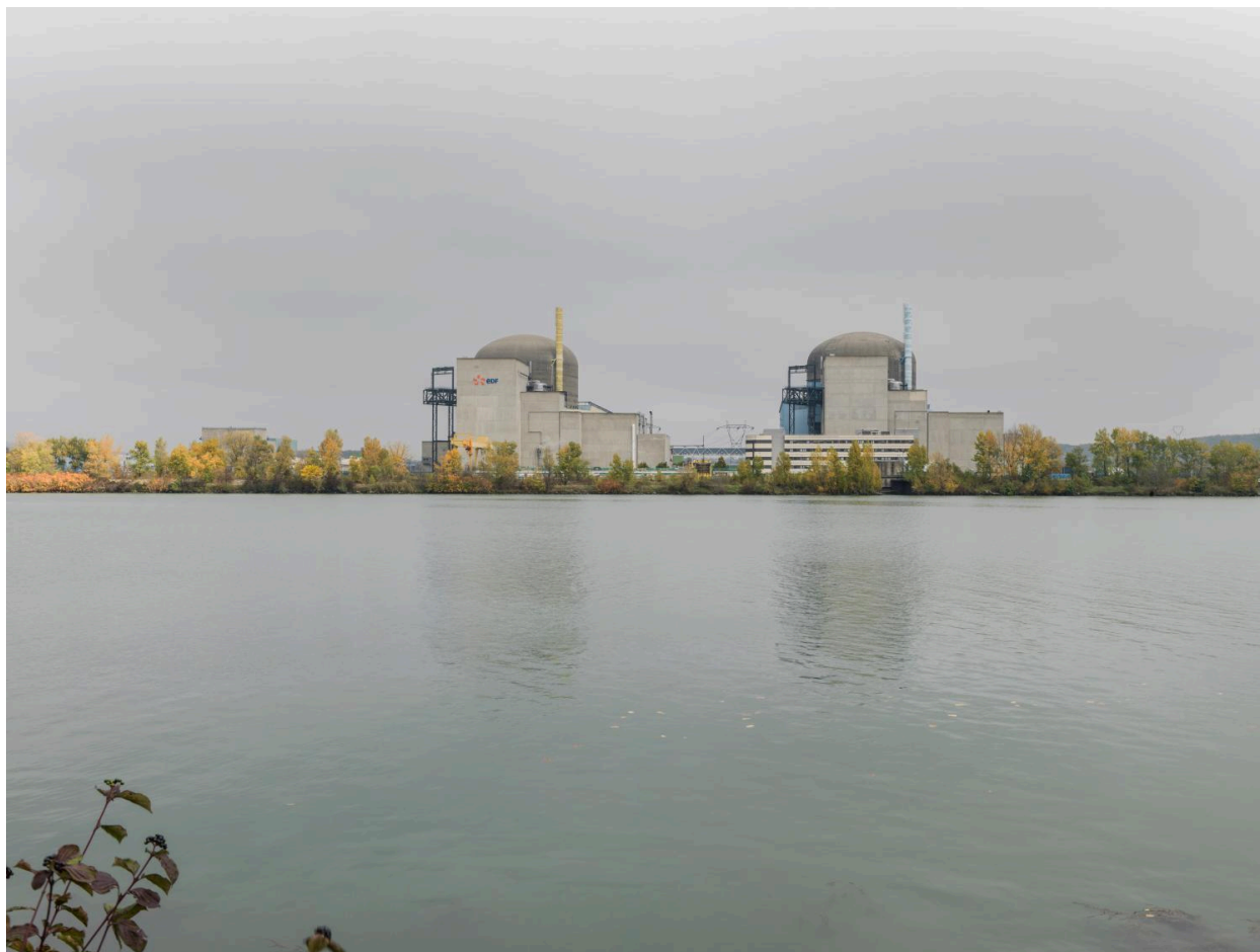
Vue d'ensemble de la centrale
