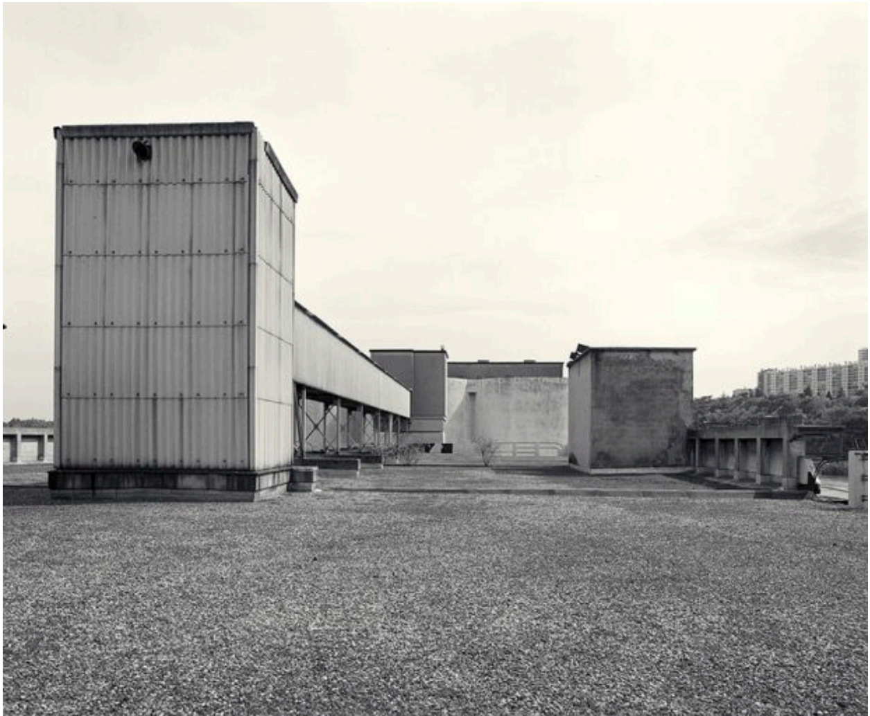
La galerie de liaison entre les silos et les ateliers depuis le nord
