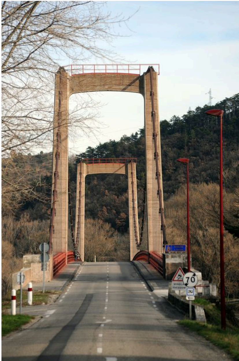
Vue générale, de dessus (depuis la rive droite)
